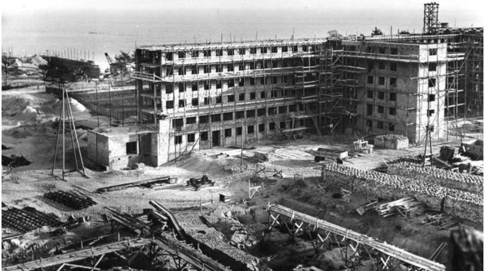
Abb. 1: Bau des „KdF“-Seebades auf der Insel Rügen, 1937
